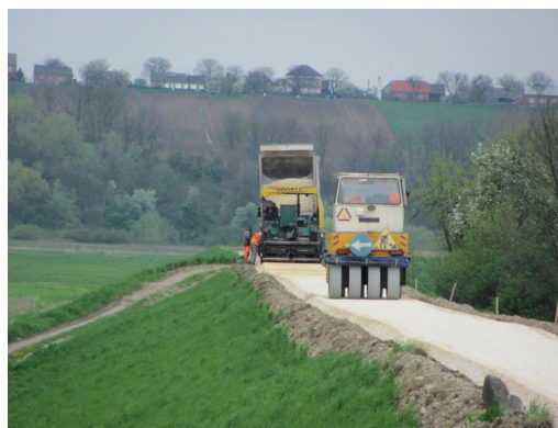
Rys. 3. Przykłady planowanych prac budowlanych, w ramach realizacji projektu VeloMałopolska, w koronie wału przeciwpowodziowego.
