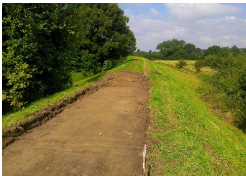
Rys. 3. Przykłady planowanych prac budowlanych, w ramach realizacji projektu VeloMałopolska, w koronie wału przeciwpowodziowego.
